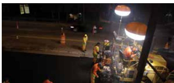
Tem ainda um **mastro extensível até 5,20m** de altura, alimentação a **220V com consumo de 2,4Kw, lâmpadas de halogéneo 2x1000W** ou lâmpadas de LED **2x500W**.
